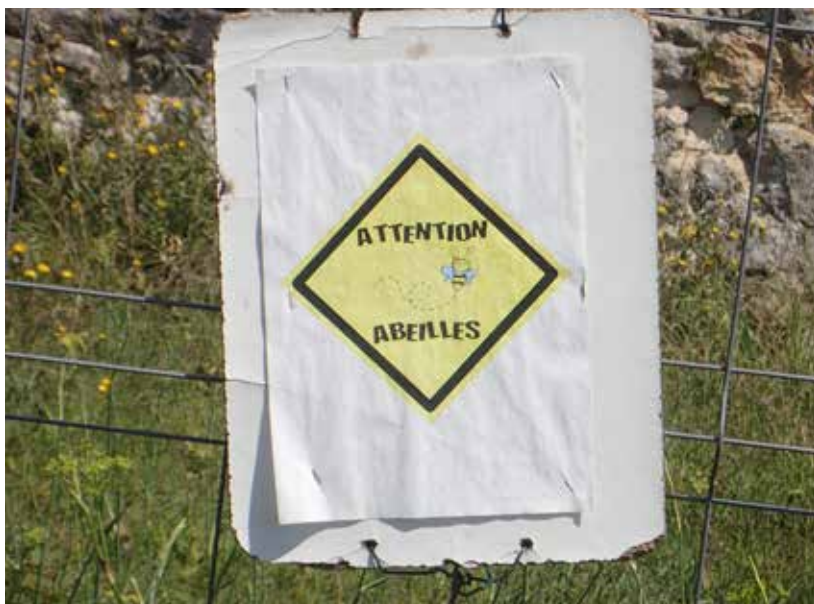
Des abeilles mellifères se sont installées dans une cavité du rempart de la citadelle de Brouage, construite au XVII ème siècle. La municipalité, plutôt que les détruire pour des raisons de sécurité, a opté pour leur protection en installant un grillage empêchant les promeneurs de s'approcher trop près de l'entrée, et donc supprimant les risques de piqûre, avec un petit panneau explicatif. Photo Vincent Albouy
