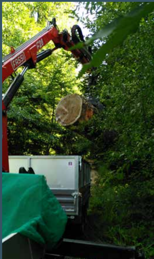
Teilweise müssen sogar Kräne zur Hilfe gezogen werden, um die schweren Baumhöhlen transportieren und in Position bringen zu können.
