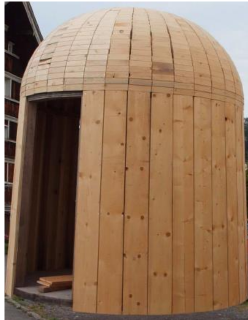
Bild 4: Pavillon im Rohbau (ohne Schindeln)
