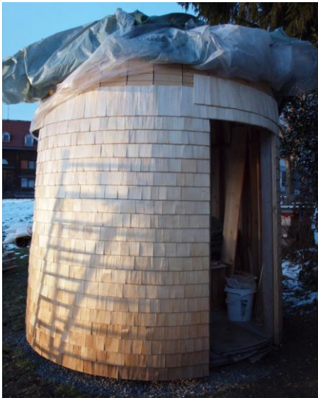
BILD 10: PROTOTYP MIT SCHINDELN KURZ VOR FERTIGSTELLUNG
