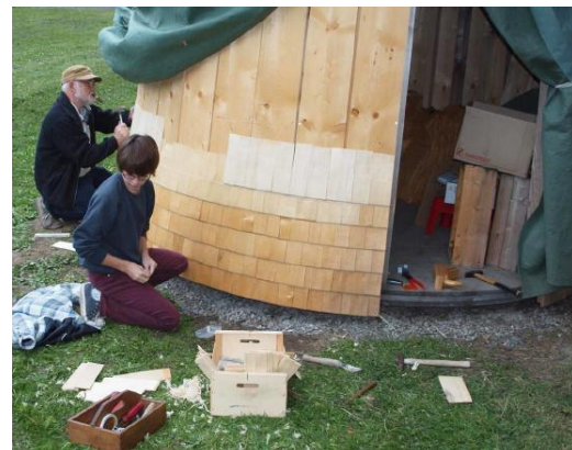
BILD 9: ANBRINGEN DER SCHINDELN
