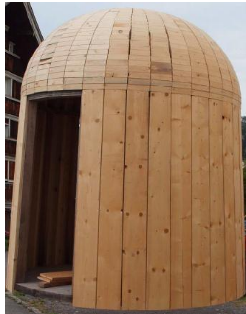
BILD 7: PILOT-PAVILLON IM ROHBAU (OHNE SCHINDELN)
